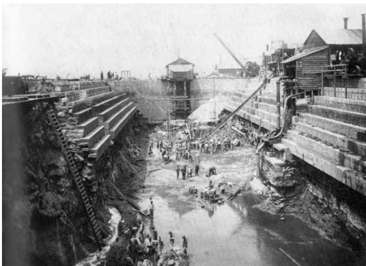
Trabajos en el dique de Gamazo. 1900. Archivo AP Santander
